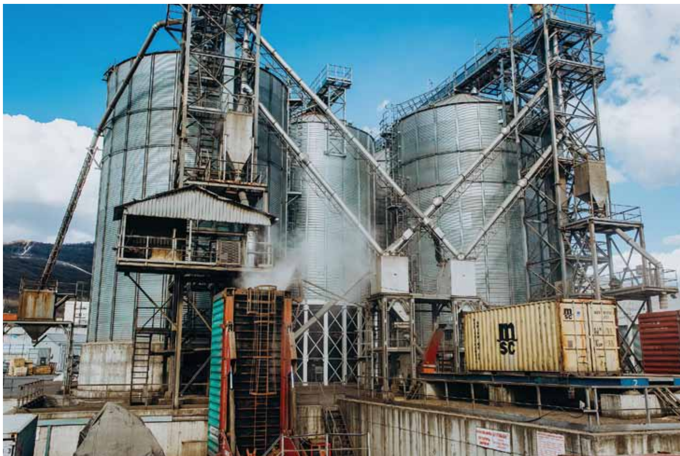
Загрузка контейнера на зерновом терминале
